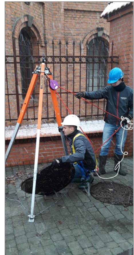
Bezpieczne zejście do studzienki kanalizacyjnej.
