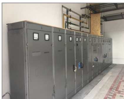
Fot. 1 Stara rozdzielnica niskiego napięcia RGNN
