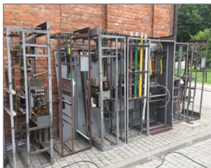
Fot.2 Zdemontowana stara rozdzielnica niskiego napięcia RGNN
